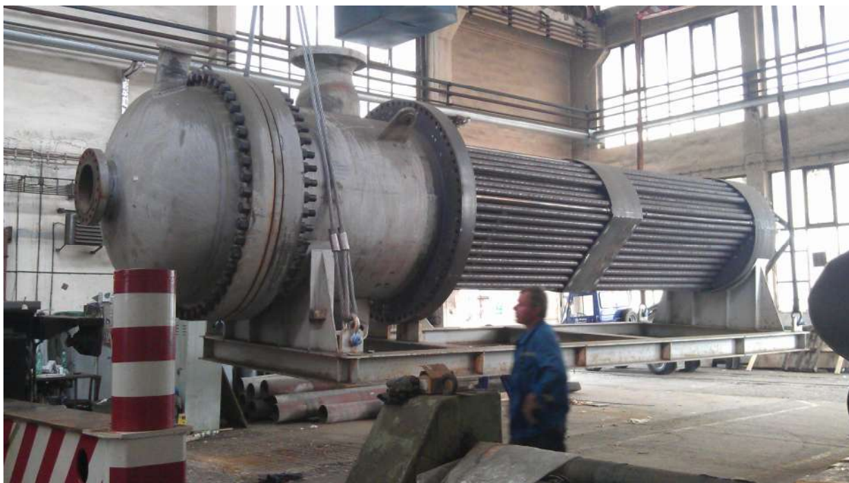
Výměna trubek a trubkovnice na chladiči 2411 E201 Česká rafinérská, a.s. 6/2013
